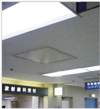
平塚市民病院様 2012年3月施工
