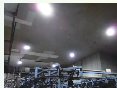
▲メッキ工場にハイブライトボックス高温タイプを フッ素加工して導入 (三条中央鍍金様)
